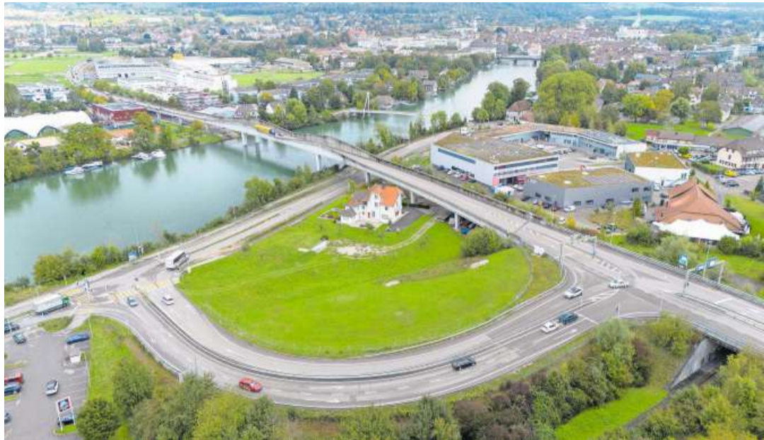
Flüssiger Verkehr auf der Westtangente: Der Knoten Lackenhof soll optimiert werden. Bild: Bruno Kissling
