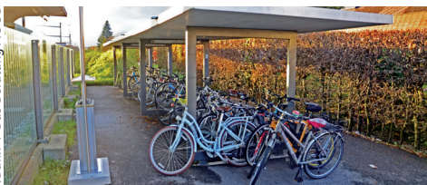
Ausbauvorschlag Deitingen Bahnhof (SBB): Bestehende überdachte Anlage um 13–15 Plätze erweitern mittels System mit Anlehnbügel, an die man Velorahmen anschliessen kann. Zusätzlich 5–6 gedeckte Plätze für Motorräder/Mofa erstellen.
