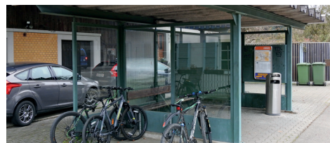
Sanierungsvorschlag für Bushaltestelle Linde in Derendingen: vorhandene Abstellanlagen mit Anlehnbügel versehen, an die man den Velorahmen abschliessen kann. Mindestens heutige Anzahl Abstellmöglichkeiten (2x 3) beibehalten.
