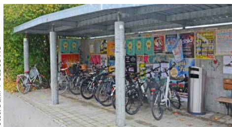
Bild 1: Abstellanlage bei der Bushaltestelle Bernstrasse in Biberist: Hier würde sinnvollerweise das bestehende Abstellsystem durch ein neues für anschliessbare Velorahmen ersetzt.
