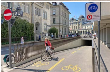
Die grosszügig gestaltete neue Bahnhofsunterquerung in Winterthur ist aufgeteilt in eine Unterführung für den Fussverkehr und eine für den Veloverkehr. Ein Vorbild für die geplante Unterführung unter dem Hauptbahnhof Solothurn?
