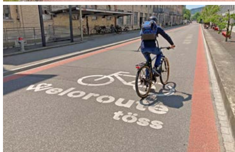
Die erste Velovorrangroute in Winterthur ist einmal mit rotem Belag (als Pilotversuch) und einmal mit roten Bändern markiert. Die schweizweit einheitliche Markierung von Velovorrangrouten ist noch nicht definiert worden.
