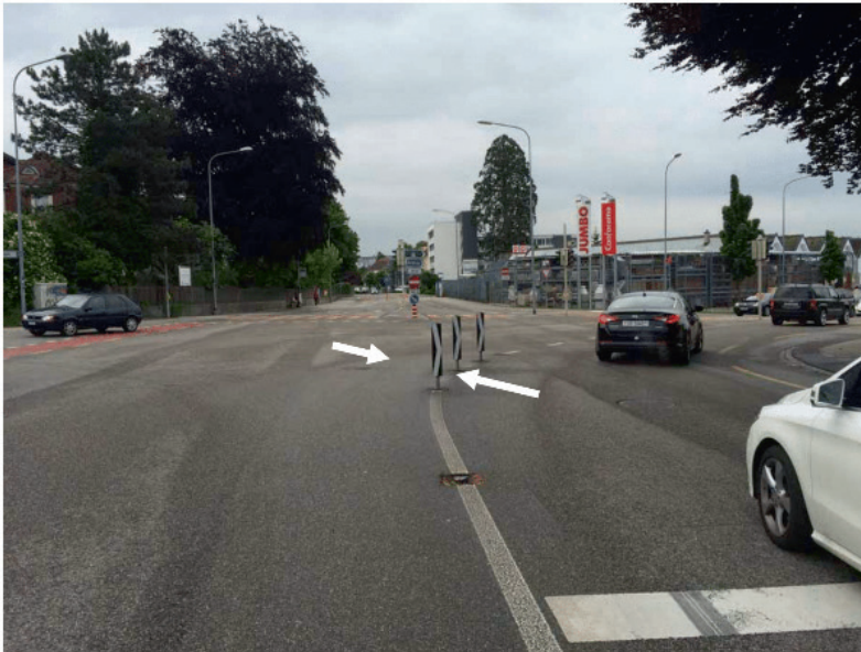
Ypsomed-Kreuzung Südseite: Hier werden die Velofahrer von zum Jumbo fahrenden Autos in die Pfosten abgedrängt.
