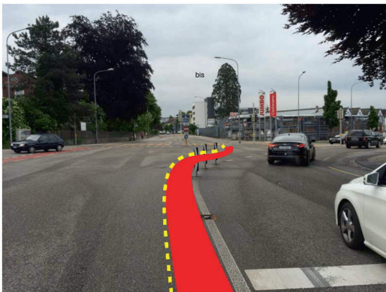
Ypsomed-Kreuzung Südseite: Fehlende Markierung
