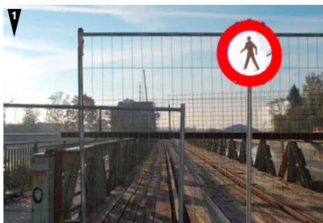
Vom Areal Attisholz-Nord zum Uferpark wird nach dessen Eröffnung auch die alte Eisenbahnbrücke für Velos befahrbar sein, da die Geländer entsprechend erhöht wurden.
